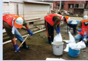
泥出しの様子
