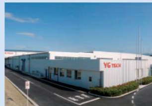
工事が完了した株式会社ワイジーテック
